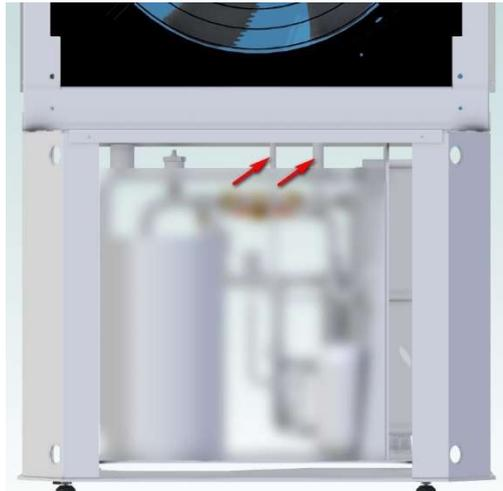
Abbildung 25: Kälteleitungen zu Verdampfer kappen und Kälteblock entfernen
